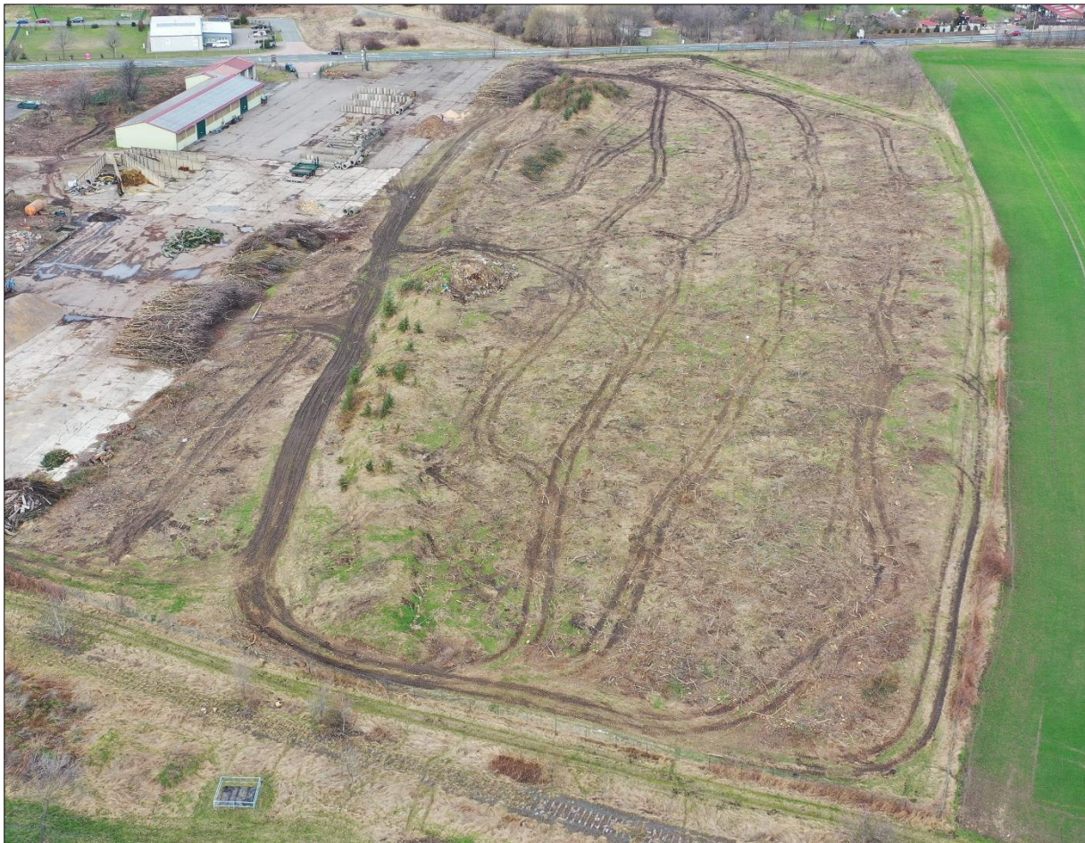
Abb. 3: Planungsraum, gesamt, Blickrichtung Norden; © Hauke – Aufnahmedatum: 20.02.2024.
