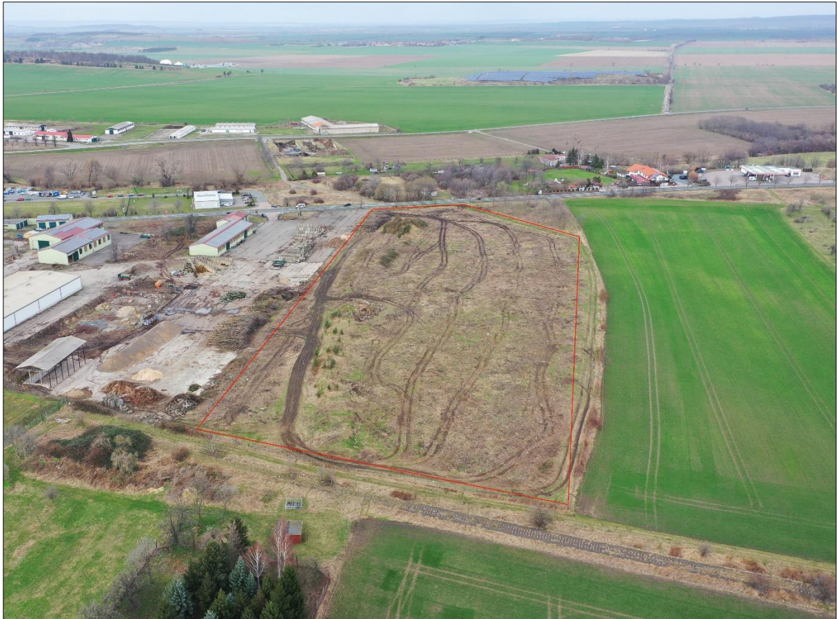
Abb. 2: Planungsraum im nahen Umfeld, Blickrichtung Norden; © Hauke – Aufnahmedatum: 20.02.2024.
