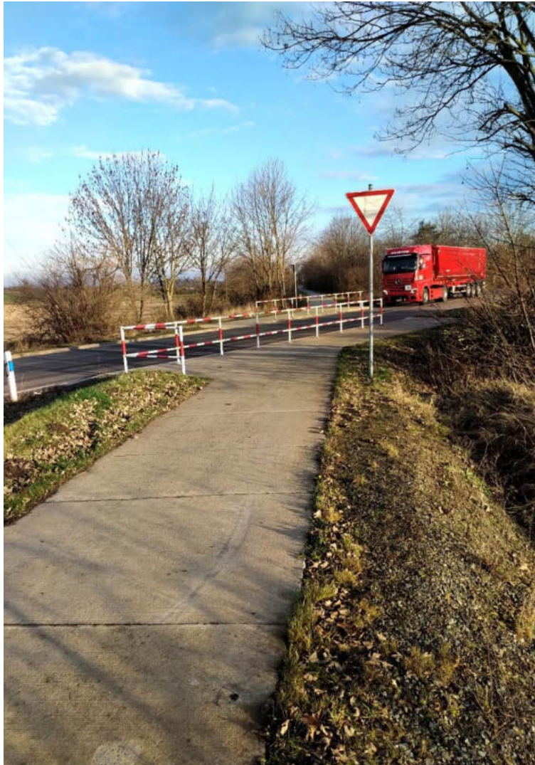
Bild 7: Vorbildliche Überführung der Ballenstedter Straße für den neuen Radweg am ehemaligen Bahndamm Aufnahme 18.12.23, E. Buhmann
