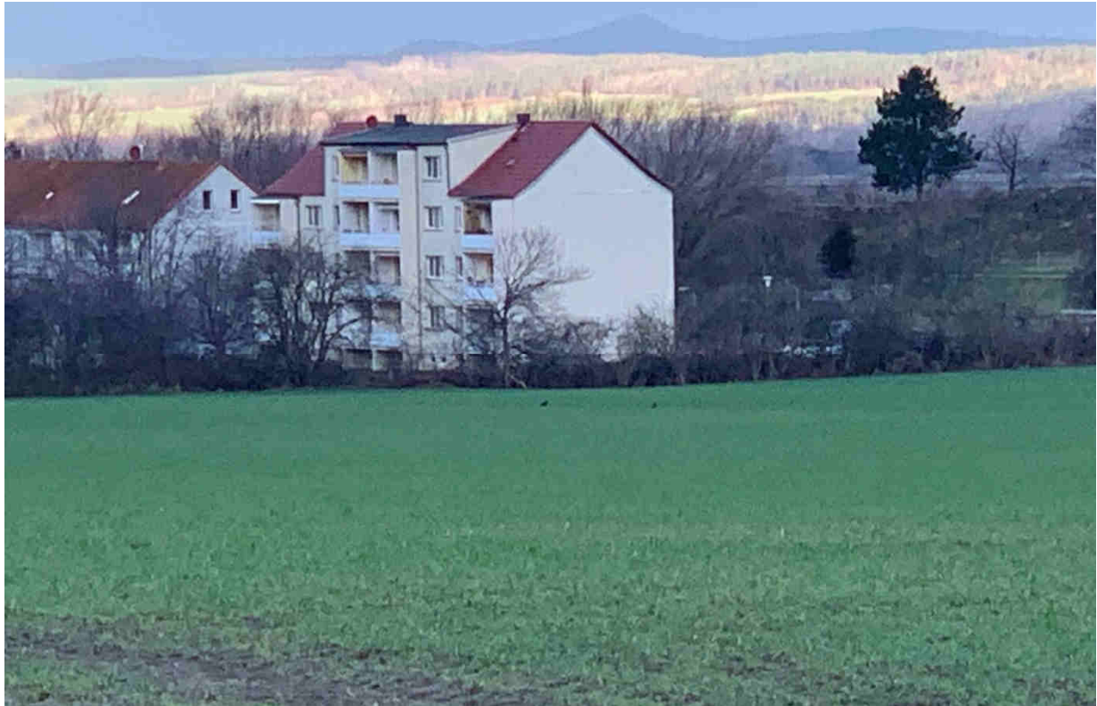
Gebäude nahe der nordwestlichen Ecke der gegenständlichen Anlage
