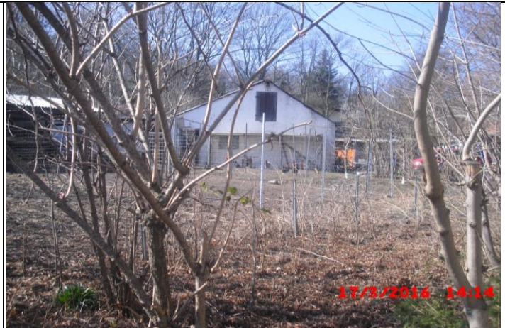
Abbildung 15 „An der Heinestraße“ - Blick nach Südwesten
