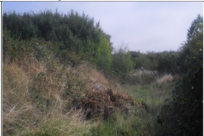
Abbildung 21 PV-Anlage „Am Mühlfeld“ - Blick nach Norden
