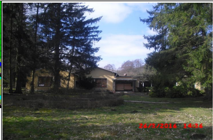
Abbildung 20 „Selkemühle“ - Blick nach Süden
