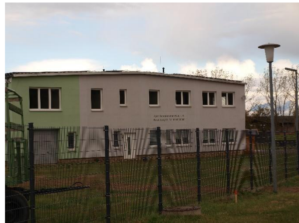
UW Roßlau mit Feldweg an der Westseite (Blick nach Norden)
