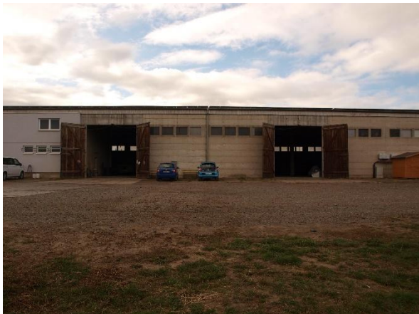
Zentrales Plangebiet mit Scheune, Verkehrsflächen, Stellplätzen (Blick nach Westen)
